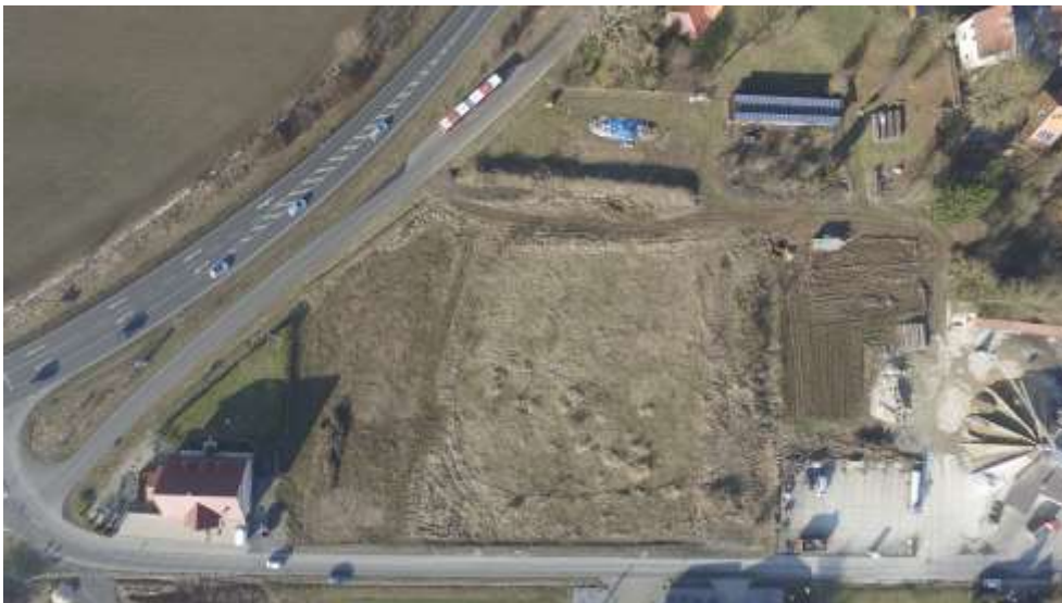
Abbildung 1: Teilbereich 1, nördlicher Bereich
