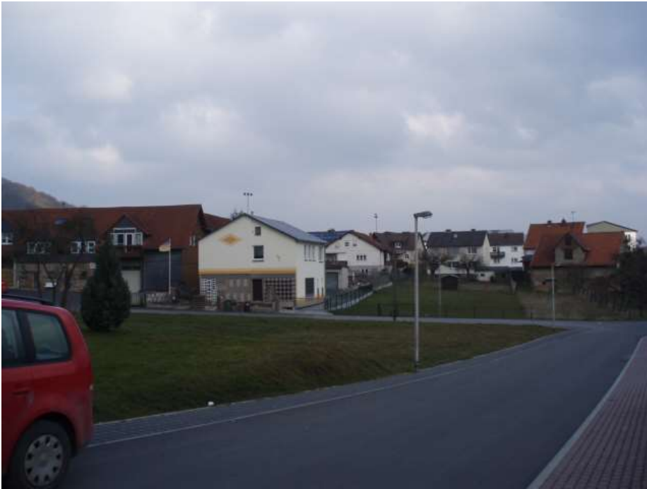
Abbildung 2: Blick auf die Bebauung nördlich der Straße „Zum Kattenstein“
